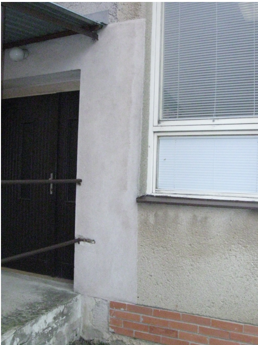
Pohled na kotvení zábradlí do nosného zdiva
