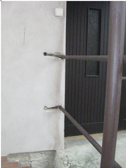
Pohled na kotvení zábradlí do nosného zdiva
